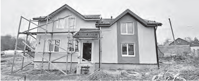
Старая и новая части дома: новая в строительных лесах
