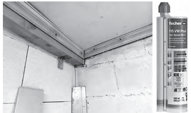
Стык внешней (керамзитобетон D500) и внутренней (фабричный автоклавный газосиликатный блок D400) стен гаража, смонтированы на химический анкер уголки, на которых лежат опорные балки
